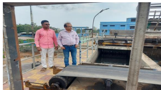
Site Visit: 76 MLD STP at Kasba Bawda, Kolhapur
